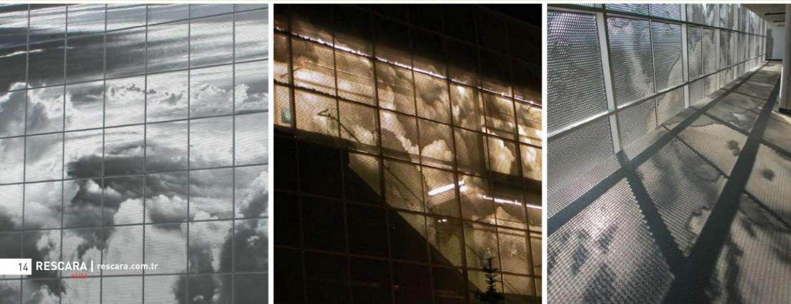
Ombræ ürünleri ile dış cephe projelerinde konseptin uygun olarak tasarımlar hayata geçirilirken; güneş ışığının levhadaki deliklerden süzülmesiyle hem iç mekanın aydınlatılması sağlanmakta hem de levha üzerindeki desenin yarattığı gölge ile tasarımın yansımaları iç mekanda da görülmektedir.
