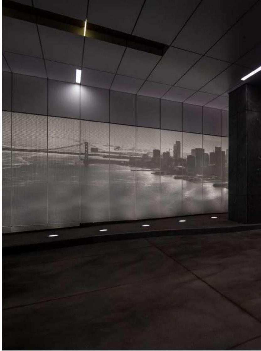
Özellikle iç mekan uygulamalarında detaylı tasarımlı olan projeler için küçük boyutlu pikseller kullanılmaktadır. Bu sebeple VGNC Hospital projesinin, otopark girişinde daha yakın mesafeden desenin algılanabilmesi için küçük pikseller tercih edilmiştir.
