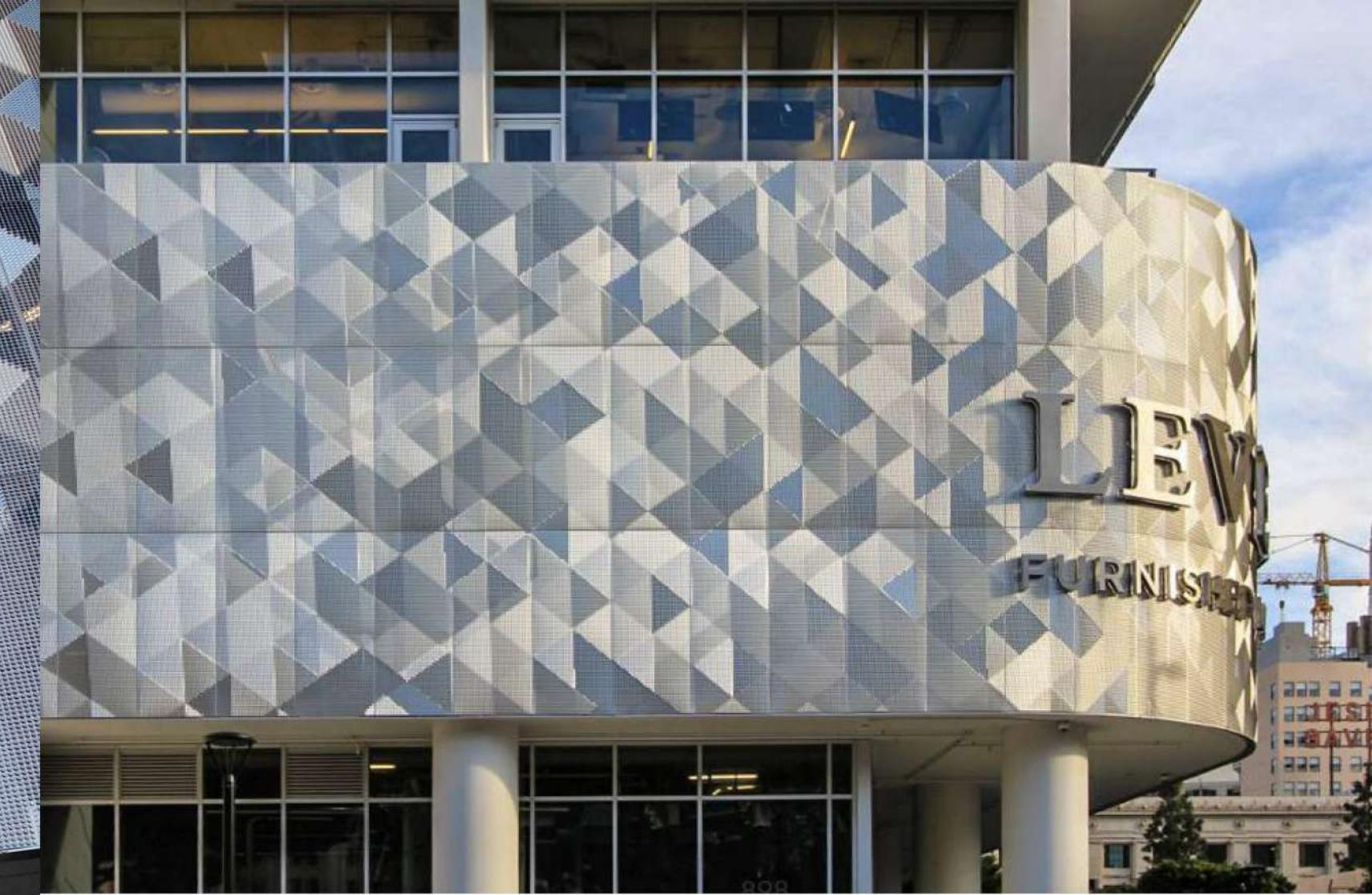
888 Olive St. projesinde kullanılan Ombrae sistemiyle, levha üzerindeki açılı delikler sayesinde hem iç mekanın havalandırılması sağlanmış hem de alüminyum levha üzerinde oluşan ışık/gölge oyunlarıyla dış cepheye estetik bir görünüm kazandırılmıştır.
